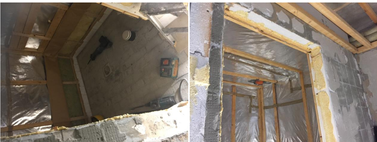
Purkutyöt on aloitettu. Saunan paneelit on purettu pois, samoin lattian laatoitukset.
